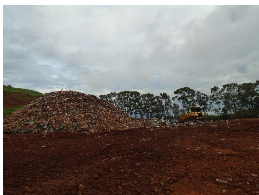
Foto 3 – Célula aberta em que está ocorrendo a compactação dos resíduos para posterior cobertura do material.
