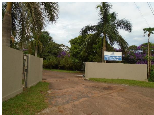
Foto 1 – Entrada para o Aterro Sanitário de Cianorte.
