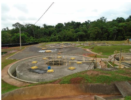
Foto 9 – Reatores anaeróbios de lodo fluidizado (RALFs).
