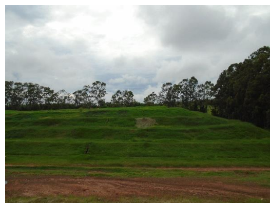
Foto 4 – Célula encerrada com sistema de drenagem de águas pluviais e canalização para chorume e gases, com flares em operação.
