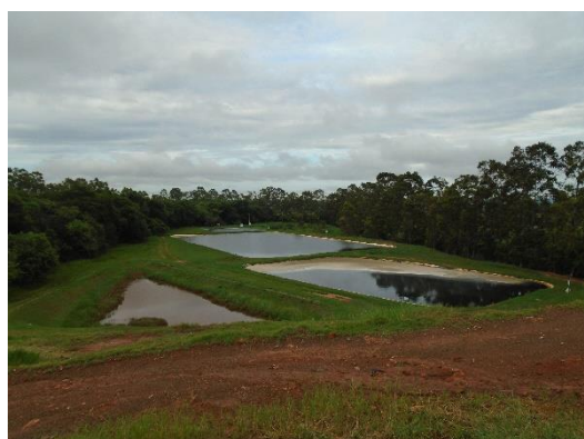
Foto 5 – Sistema com as lagoas de tratamento e com uma bacia de contenção para águas pluviais.
