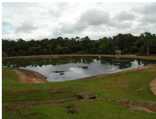
Foto 12 – Lagoa desativada utilizada para armazenamento de lodo do tratamento físico-químico.
